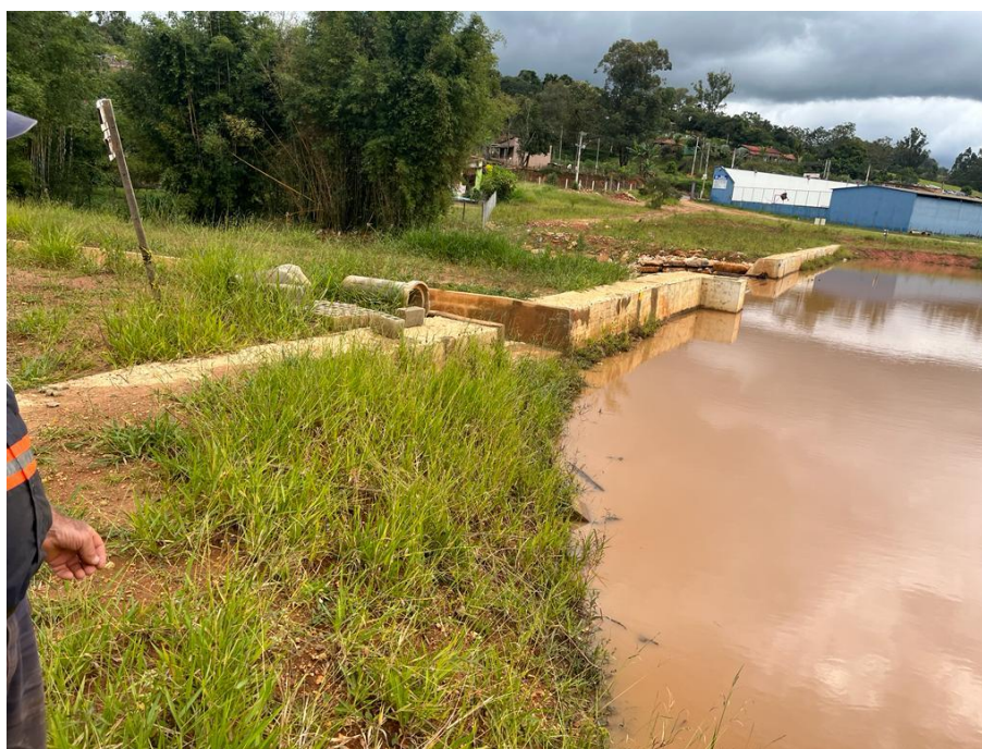
Figura 1 – Ponto de captação na Barragem Gargatá.
