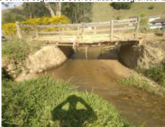
- Ponte III do Bairro Taboão com as seguintes Coordenadas Geográficas: 22°11'14.8"S 46°25'05.9"W.
