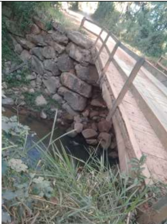
- Ponte II do Bairro Taboão com as seguintes Coordenadas Geográficas: 22°11'53.0"S 46°25'34.7"W.
